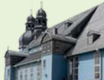
Baustelle Marktkirche Clausthal
